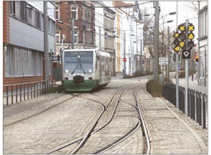
...medan motorvagnarna som från järnvägen leds in i centrum är normalspåriga. Spåranläggningen är nog så komplicerad, för att inte tala om signalerna, som här även visar växlarnas lägen.
