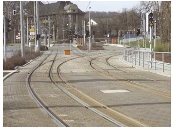
Här lämnar järnvägsfordonen stadsspårvägen i riktning höger. Också på denna plats noteras komplicerad spåranläggning, en följd av kombinationen meter- och normalspår.
