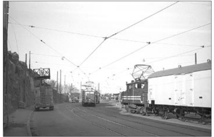
På Södra Lidingöbanan i Stockholm förekom godstrafik mellan bangården i Värtan och industrierna på ön. Godståg och Lidingötåg samsas här på Ropsten hösten 1966.
