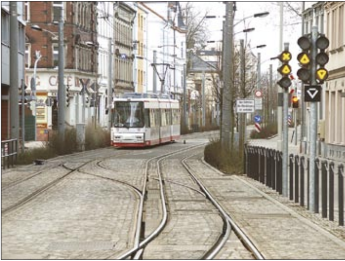
Spårvägens och järnvägens spårvidd måste överensstämna, om inte tre- eller flerskenspår anläggs, som här Zwickau i Tyskland. Stadsspårvägen är meterspårig...
