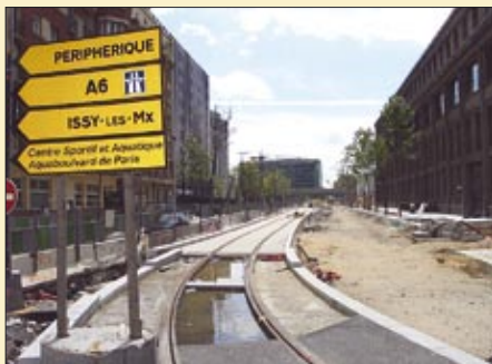
Trafikomläggning i samband med spårvägsbyggnationen.
