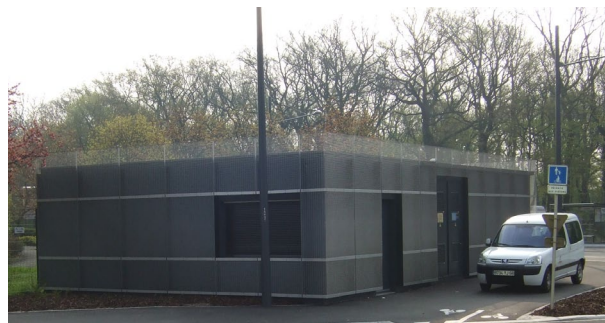
Omformerstation for kørestrøm.
